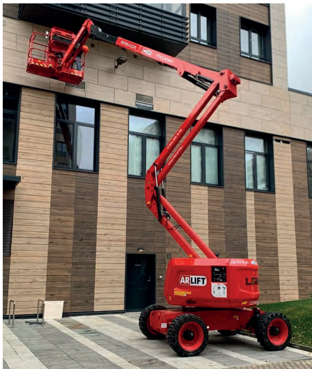
МОНТАЖ ФАСАДНЫХ ПАНЕЛЕЙ
