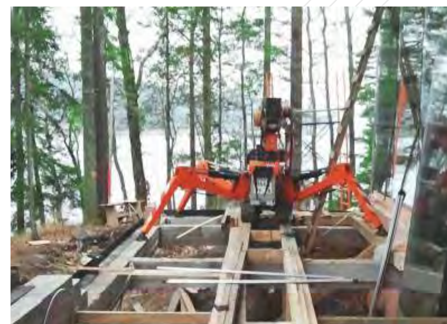
Монтаж в труднопроходимых условиях
