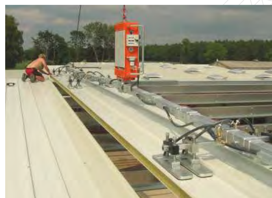
Монтаж кровельных сэндвич-панелей
