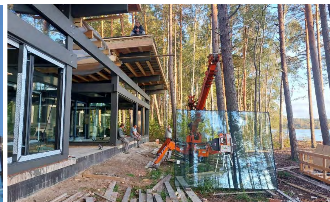
Монтаж изогнутого стекла
