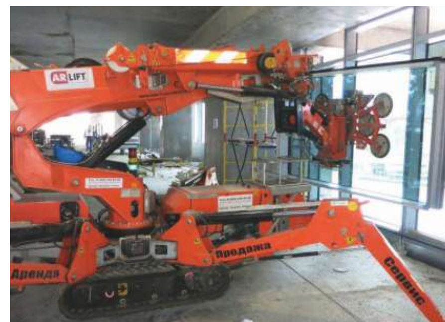
Монтаж стекла изнутри
