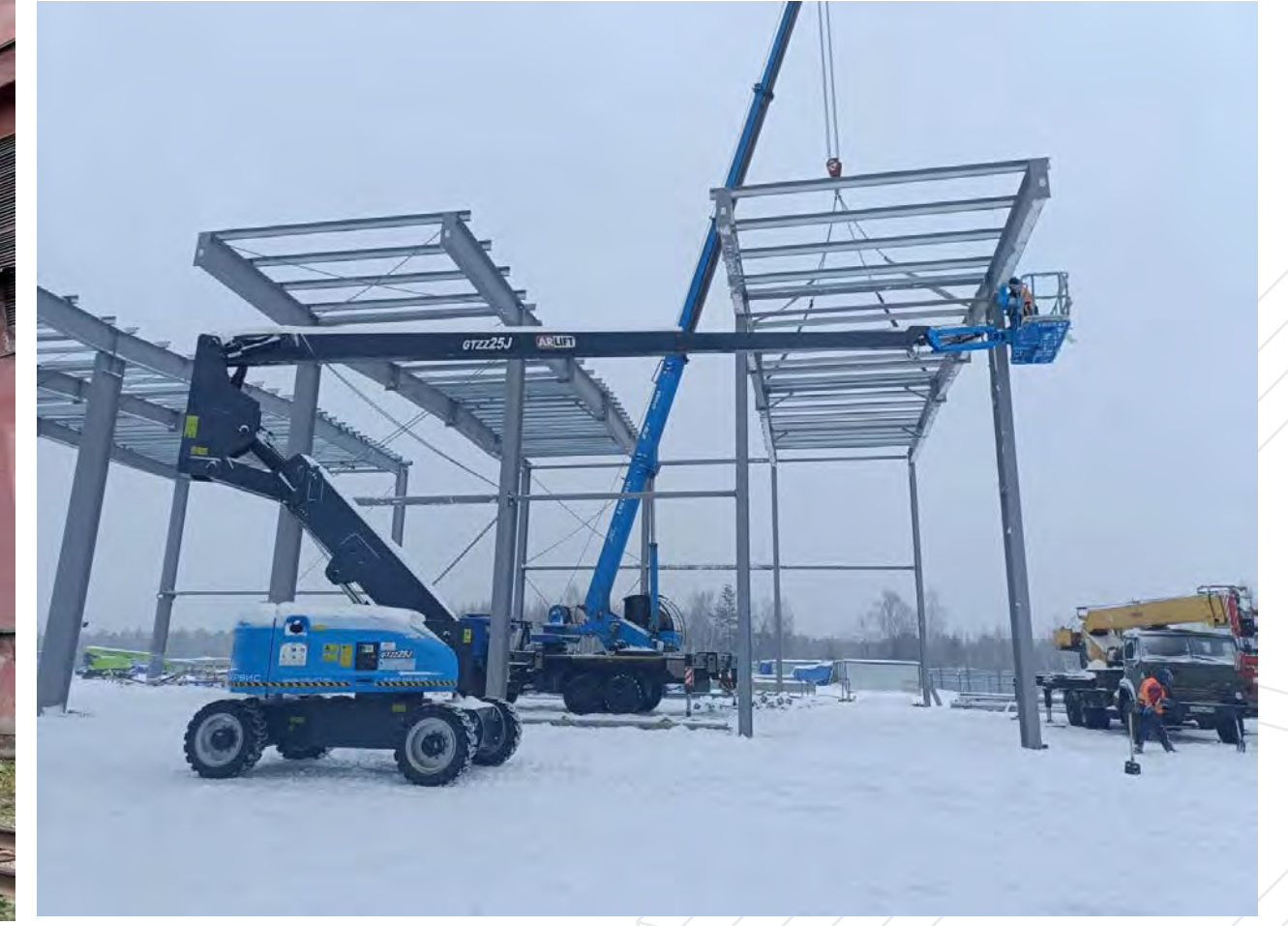
МОНТАЖ МЕТАЛЛОКОНСТРУКЦИЙ
