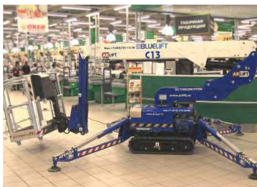
Установка и обслуживание оборудования
