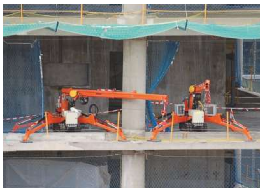
Работа с перекрытия
