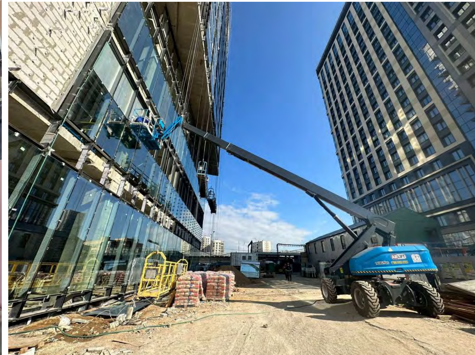
МОНТАЖ НАПРАВЛЯЮЩИХ ДЛЯ ОСТЕКЛЕНИЯ
