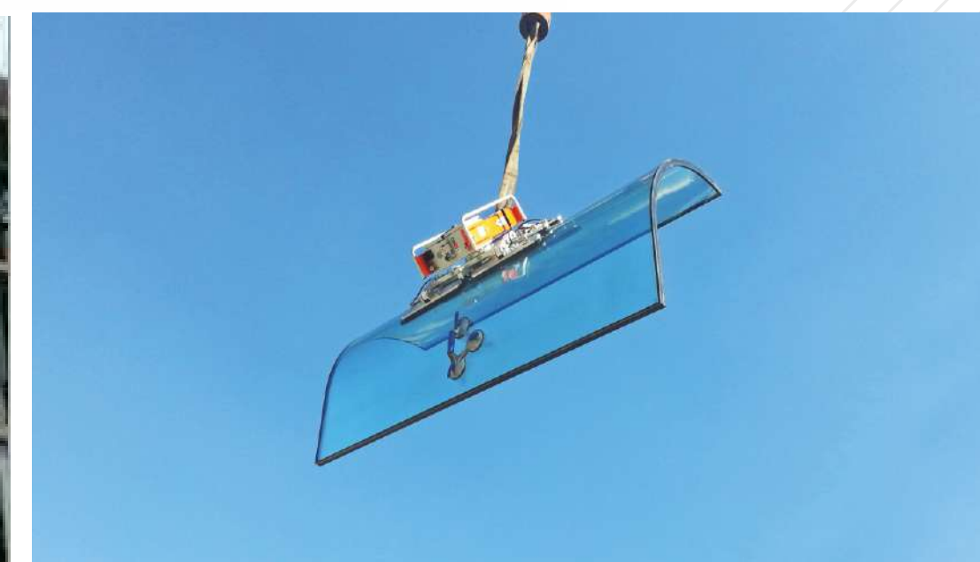
Монтаж изогнутого стекла
